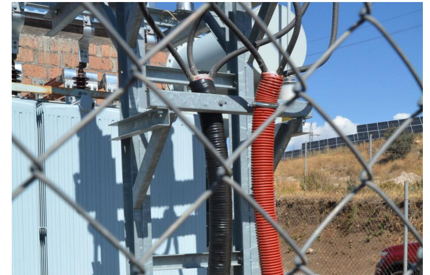
Protection of cable conduits
